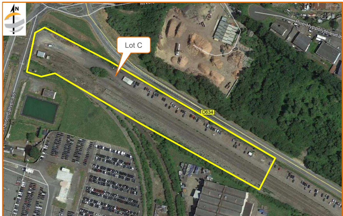
Vue aérienne de la zone d'étude (source : Google Earth)
